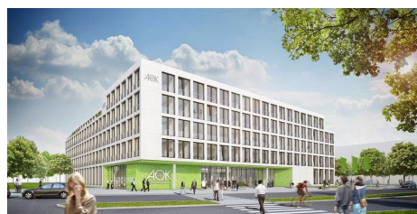
Green Building DGNB "Gold" im Essener Universitätsviertel Mieter: AOK Rheinland / Hamburg
