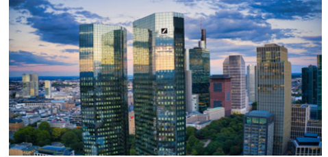
Deutsche Bank Türme in Frankfurt; Double-Net-Vertrag bis 31.12.2036 , Green Building LEED "Platin" und DGNB "Gold", 100%ige Anpassung an die Inflationsrate
